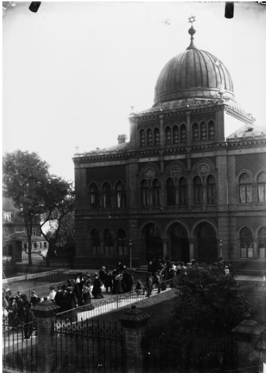
Die Lübecker Synagoge in der St.-Annen-Straße, 1904.
